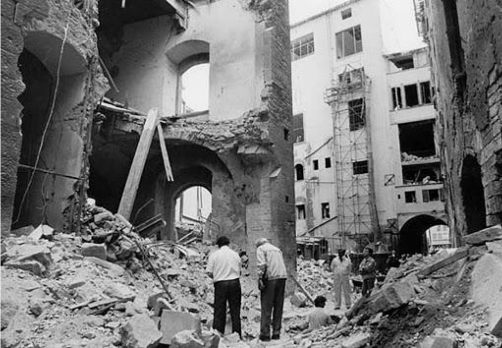
Strage dei Georgofili a Firenze.
