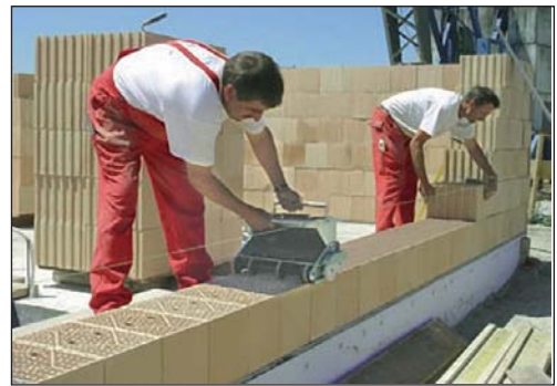
Fig. 6 Struttura portante verticale perimetrale realizzata in blocchi di laterizio alveolato rettificato. Le pareti rettificate dei blocchi assicurano dimensioni precise e permettono un accostamento laterale senza fessure e senza malta e quindi una significativa riduzione dei ponti termici. I blocchi vengono allettati solo orizzontalmente con giunti di malta sottilissimi, stesa a rullo, consentendo di eseguire murature monostrato ad alta efficienza energetica, senza l'ausilio di isolanti.
