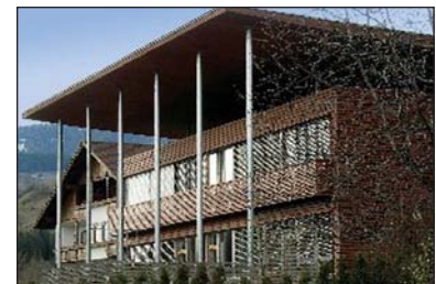
Fig. 14 Val Pusteria, Falses, Brunico. Casa clima A+. Arch. Mahlneht. Sporto di copertura staccato ed autonomo.
