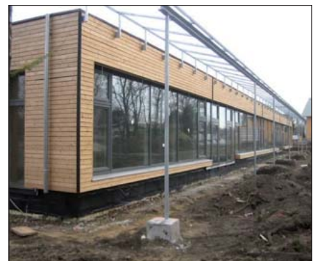
Fig. 20 Austria, Vienna, Deutsch Wagram, Cantiere di un asilo (2009). Progetto Arch. Reinberg. Facciata con rivestimento ligneo.
