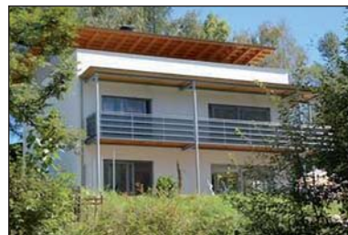
Fig. 13 Val Pusteria, Riscone, Brunico. Casa clima A. Arch. B. Rubner. Balconi e pensiline su struttura indipendente.
