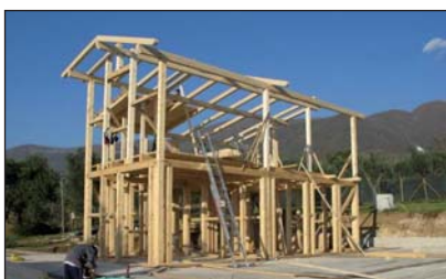
Figg. 3-5 Strutture intelaiate: in legno, cemento armato e acciaio. Le relative strutture opache verticali perimetrali andranno a "tamponare" successivamente gli spazi lasciati liberi dallo scheletro portante.
