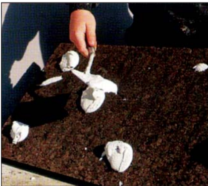
Fig. 15 Applicazione collante traspirante su pannello di sughero.
