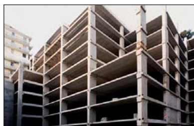
Figg. 3-5 Strutture intelaiate: in legno, cemento armato e acciaio. Le relative strutture opache verticali perimetrali andranno a "tamponare" successivamente gli spazi lasciati liberi dallo scheletro portante.
