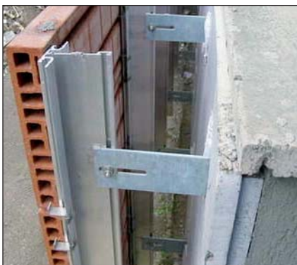
Fig. 18 Particolare supporti agli elementi in laterizio e camera di ventilazione.
