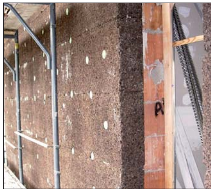
Fig. 16 Pannelli di sughero applicati alla muratura con tassellatura meccanica.
