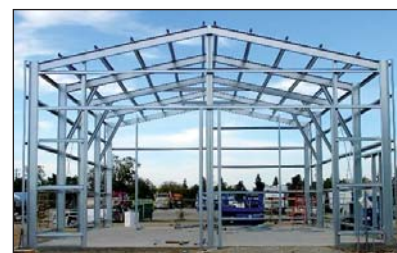
Figg. 3-5 Strutture intelaiate: in legno, cemento armato e acciaio. Le relative strutture opache verticali perimetrali andranno a "tamponare" successivamente gli spazi lasciati liberi dallo scheletro portante.
