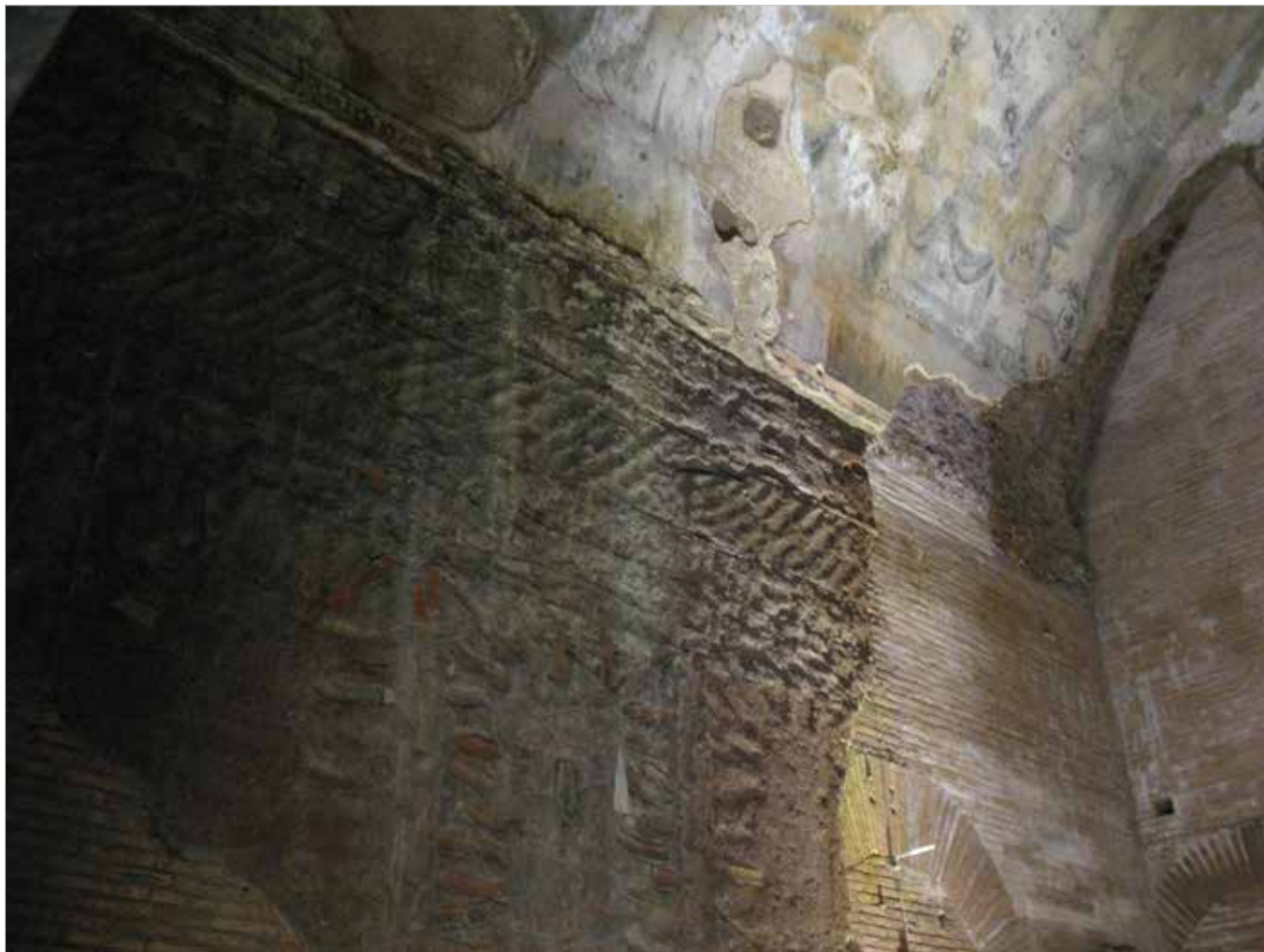
Domus Aurea , «sala della volta delle civette», decorazione pittorica sulla volta a botte al di sopra di una cornice a stucco (perduta) e in opus sectile su pareti e pavimento (ben visibili le impronte lasciate sulla malta di allettamento), intonata con un imperatore amante di pietre preziose e manufatti lapidei caratterizzati da effetti di luminescenza (64-68 d.C.).
