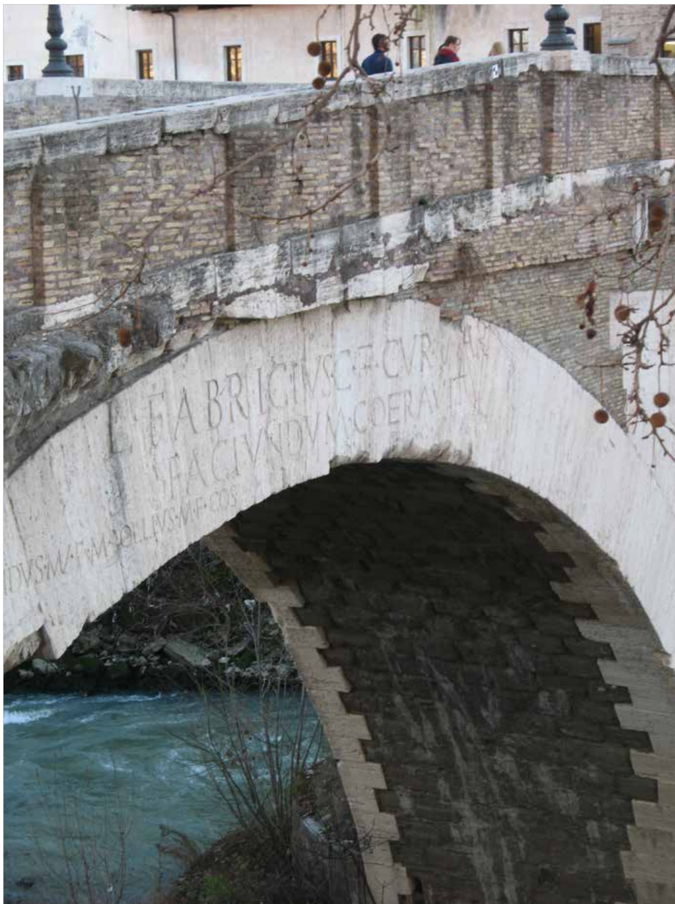
Roma, Ponte Fabricio, costituito da due arcate a sesto ribassato, dettaglio della dedica (62 a.C.).
